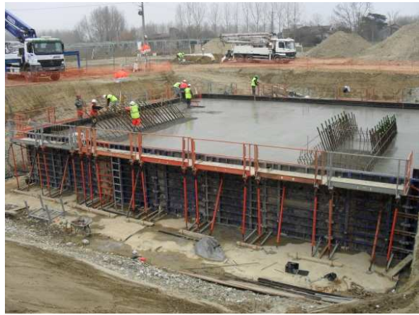
Semelle du massif d'ancrage
