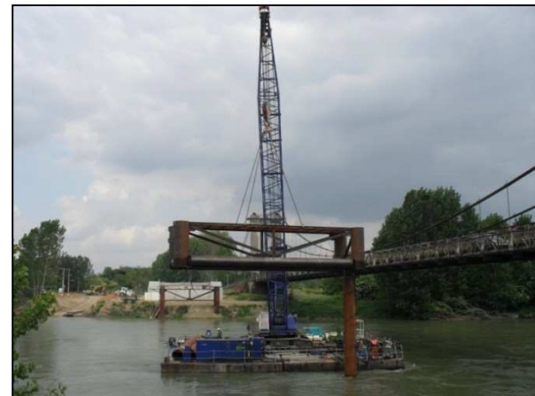
Battage des tubes pour réalisation palées provisoires
