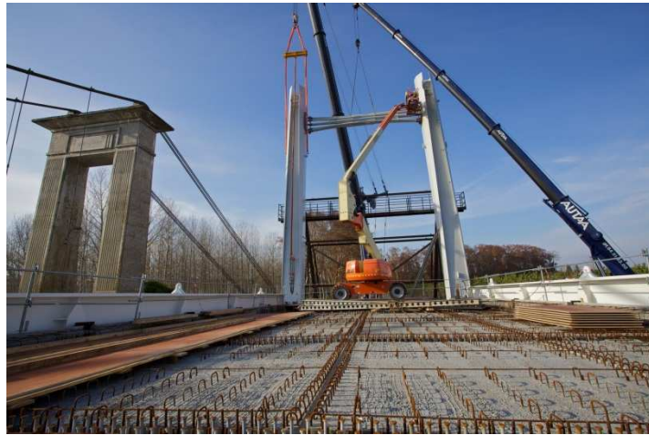
Pose de l'entretoise entre les pylônes
