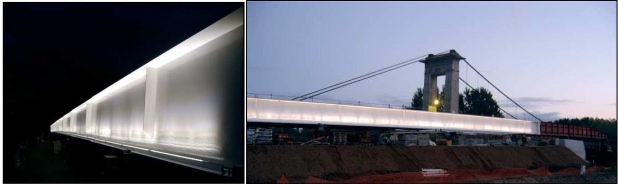
Essai d'éclairage de la charpente métallique
