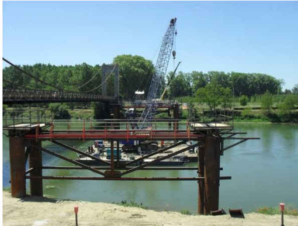
Vue d'ensemble palées provisoires
