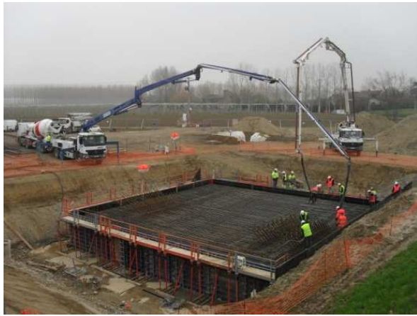
Semelle du massif d'ancrage
