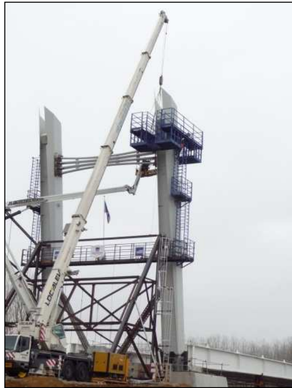
Pose des passerelles d'accès en tête de pylône
