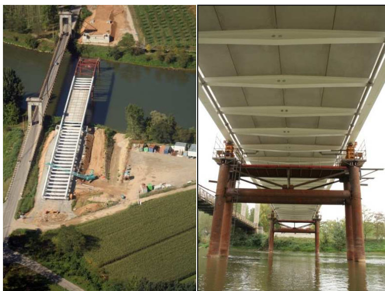
Vue d'ensemble premier lançage
