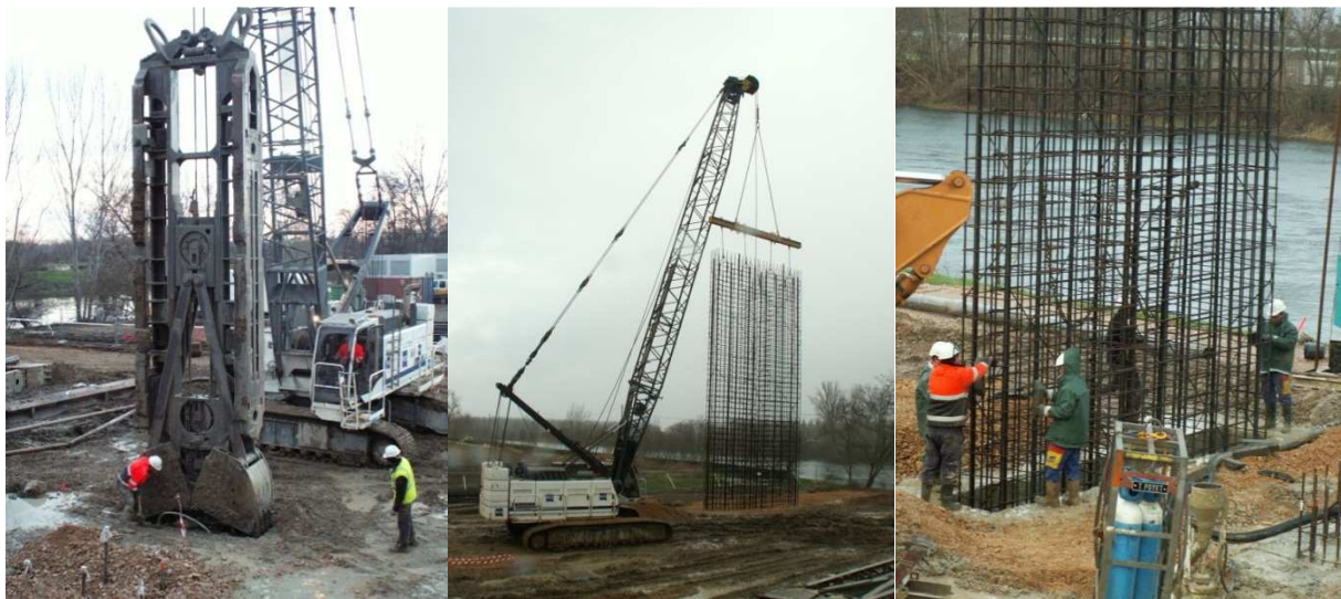
Barrettes de fondations
