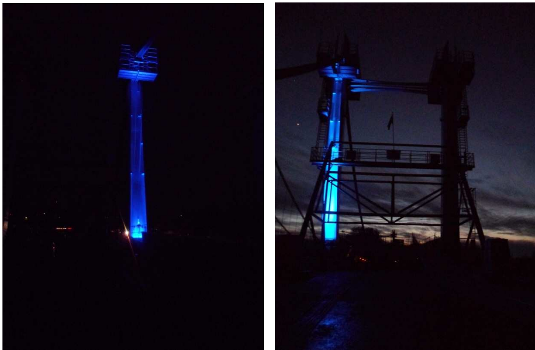
Essai d'éclairage des pylônes
