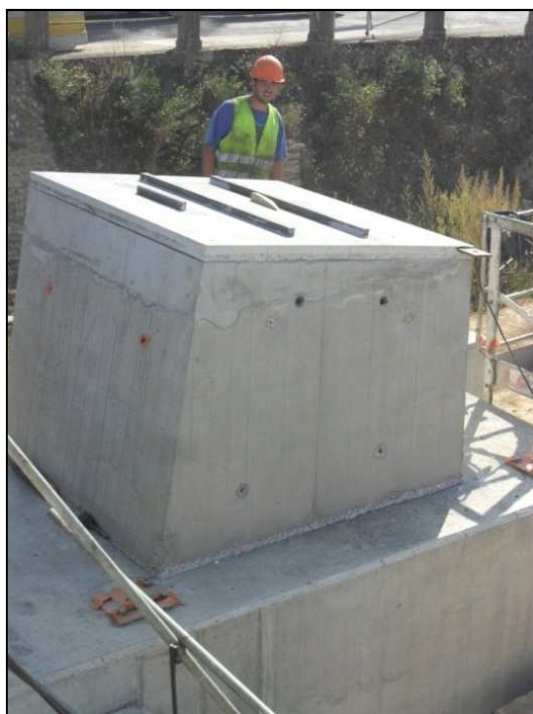
Massif support des pylônes
