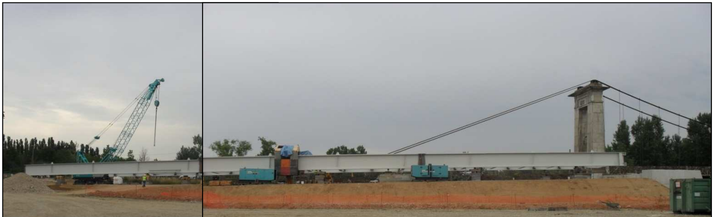
Assemblage charpente métallique rive droite
