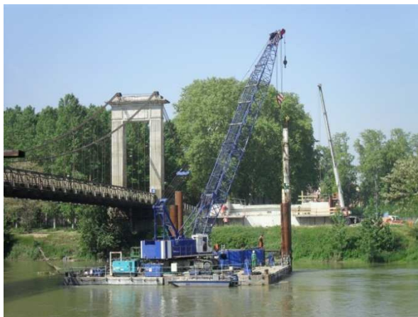
Battage des tubes pour réalisation palées provisoires
