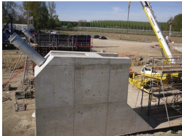
Elévations du massif d'ancrage
