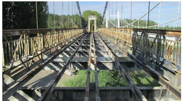
*Fin de démolition du tablier béton*
