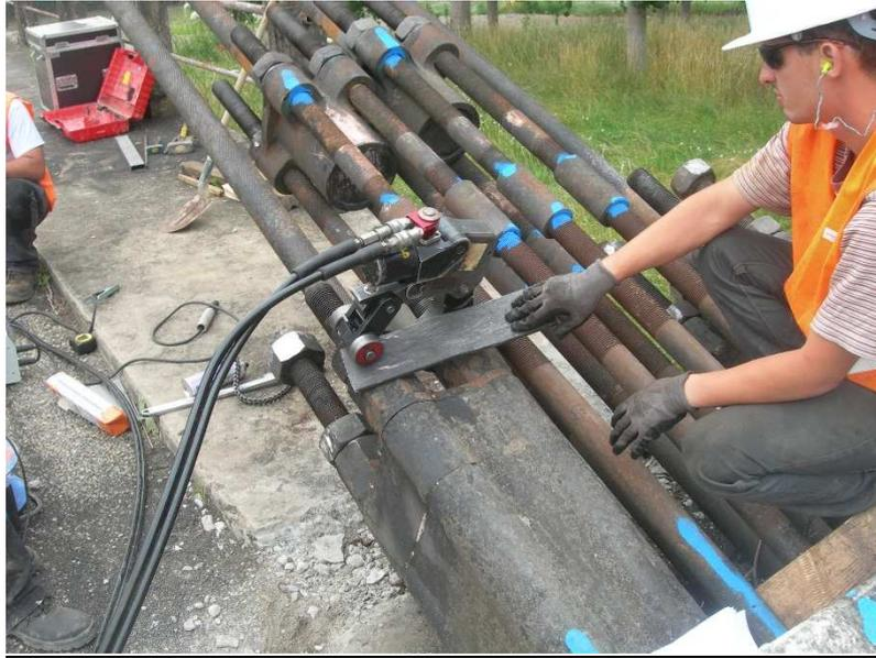
*Détente des câbles porteurs au niveau des ancrages*
