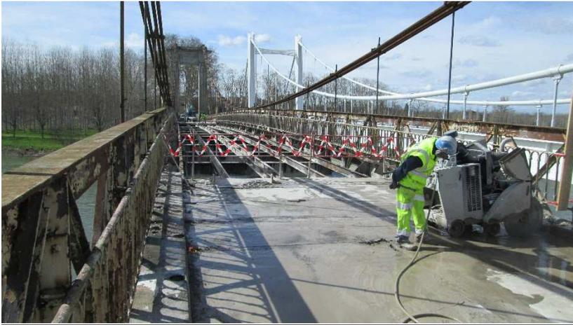
*Sciage du tablier béton*
