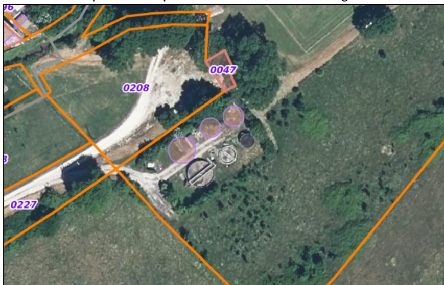
Figure 20 : Vue aérienne STEP Montaigu de Quercy
