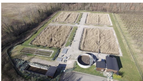
Figure 7 : Photo de l'UTMV de Nègrepelisse (source :SDD82)
