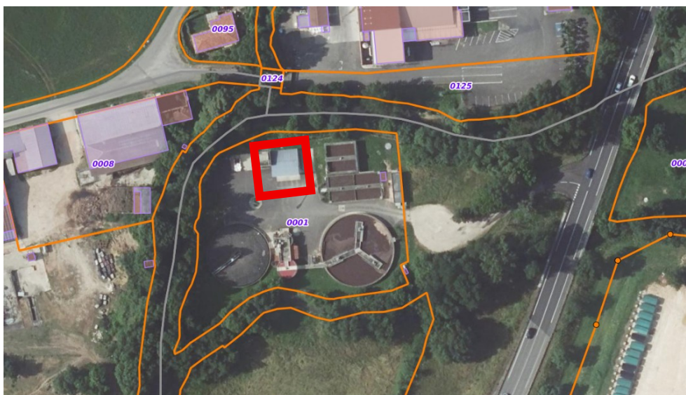
Figure 19 : Vue aérienne STEP Caussade
