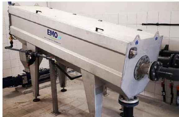
Figure 23 : Exemple de tambour d'égouttage
