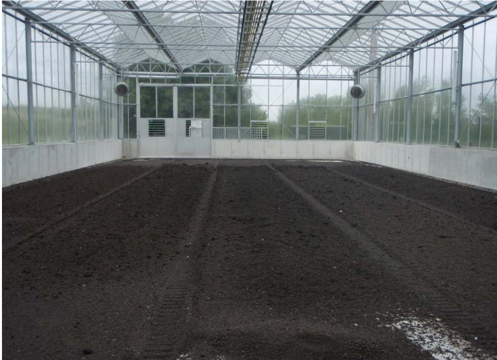
Figure 32 : Photo serre de séchage solaire (source : ©ETEN Env- STEP Montbeton)
