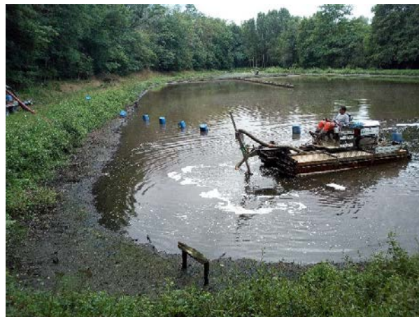
Figure 24 : Photo curage de lagune (source : PRIMA Ingénierie)
