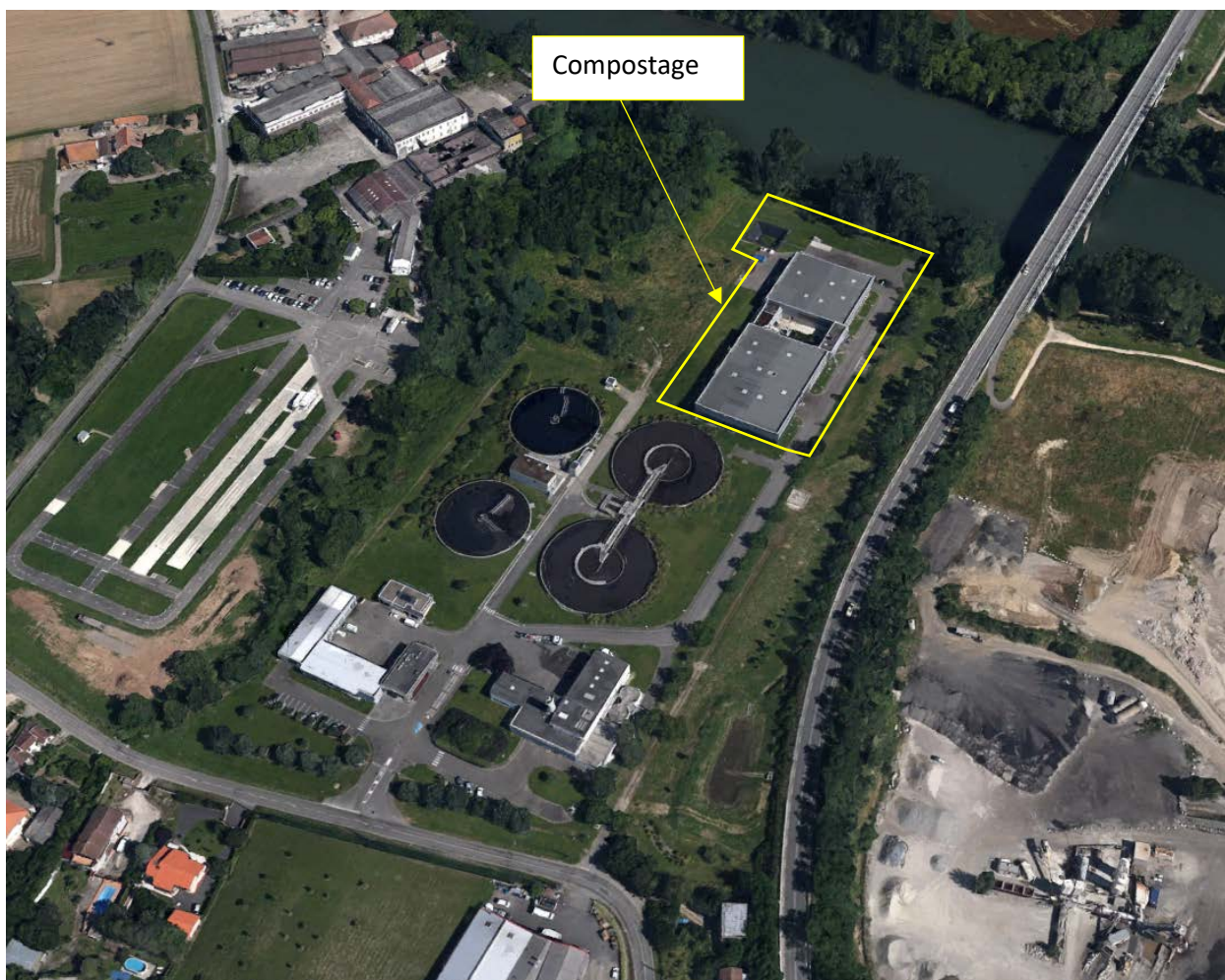
Figure 44 : Vue aérienne du site de compostage
