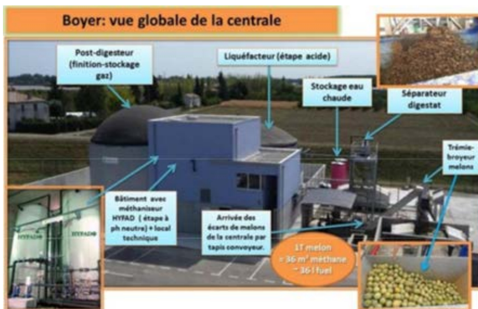
Figure 48 : Vue globale de l'unité de méthanisation Boyer biométhanisation (source : Boyer SAS)
