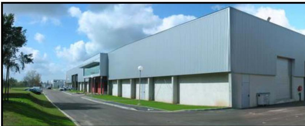
Figure 43 : Bâtiment de compostage © RPQS 2020
