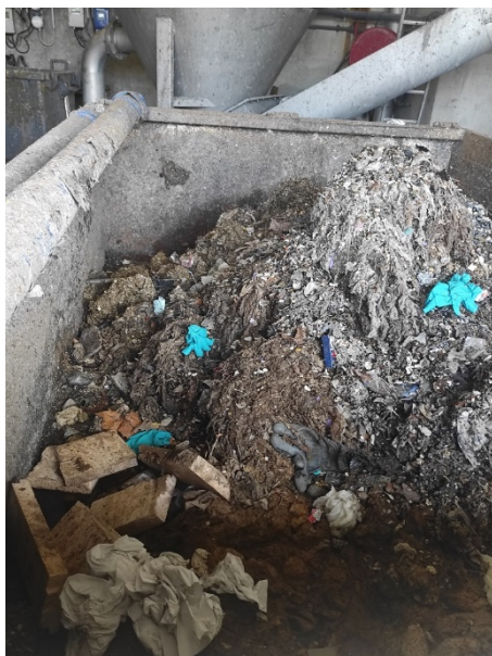
Figure 2 : Collecte des refus de dégrillage sur la station de Montauban-ville © ETEN environnement
