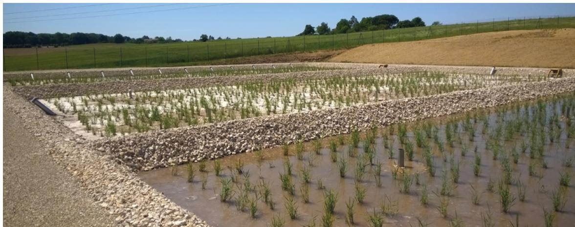
Filtres plantés de roseaux, lors du démarrage d'une station d'épuration,
