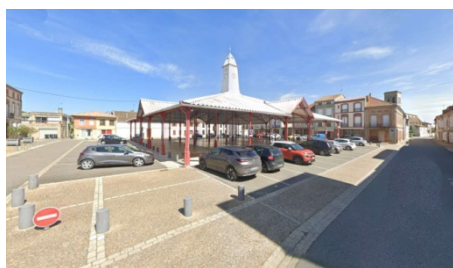
La Halle et sa place
