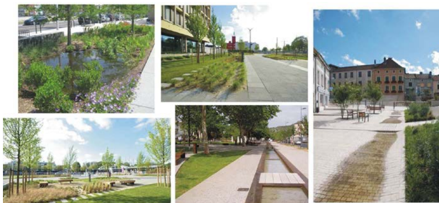
Exemple d'aménagements collectant les eaux de ruissellements : jardin de pluie, noue minérale ou végétale
