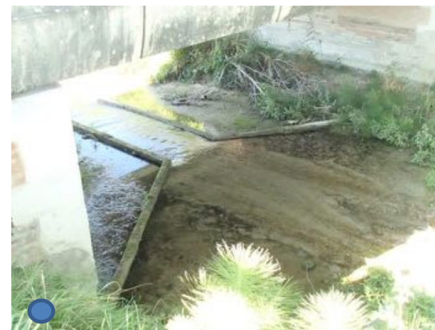
Création d'un chenal d'étiage sur un radier béton afin de restaurer la continuité écologique - 2010
