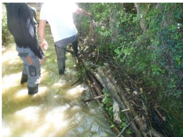
Création de sous berges par fixation de bois mort en pied de berge (La Vaysse : Bruniquel) - 2016
