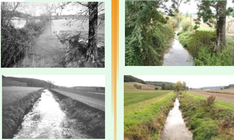
Photos de la Grande Séoune prises en 2000 puis 2014 : Vue amont et aval du pont de la D60 sur la commune de Touffailles.
