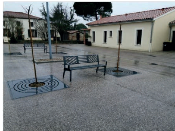
Pommevic : Aménagement de la place
