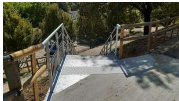
Collège A. Perbosc à Lafrançaise : réfection escalier
