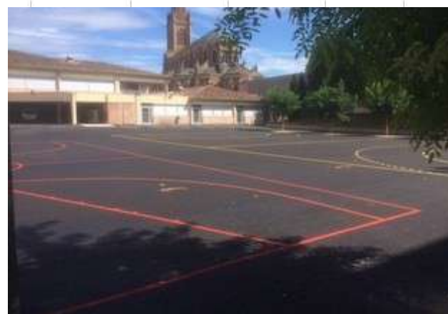
Collège J. Jaurès à Montauban : réfection de la cour
