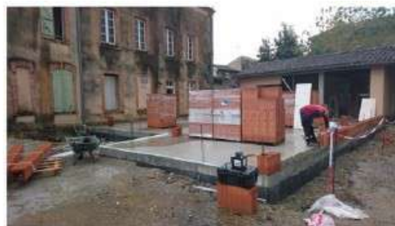
Travaux MDS de Montech
