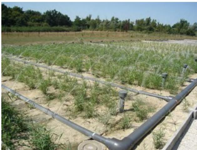
*Station d'épuration filtres plans de roseaux*
